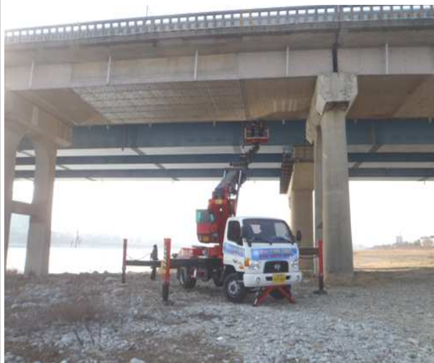
고소작업차를 이용한 외관조사
