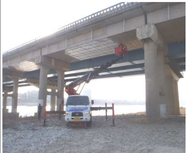
고소작업차를 이용한 외관조사
